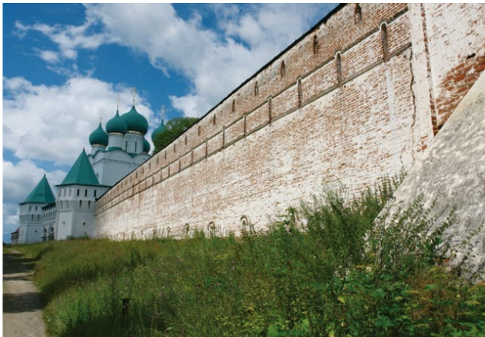
Рис. 13. Тип 3 прясел: прясла без лопаток и без выступающей верхней части. Прысло между воротным комплексом у ц. Сергия и Юго-Восточной башней. Фото автора, 2023 г.
