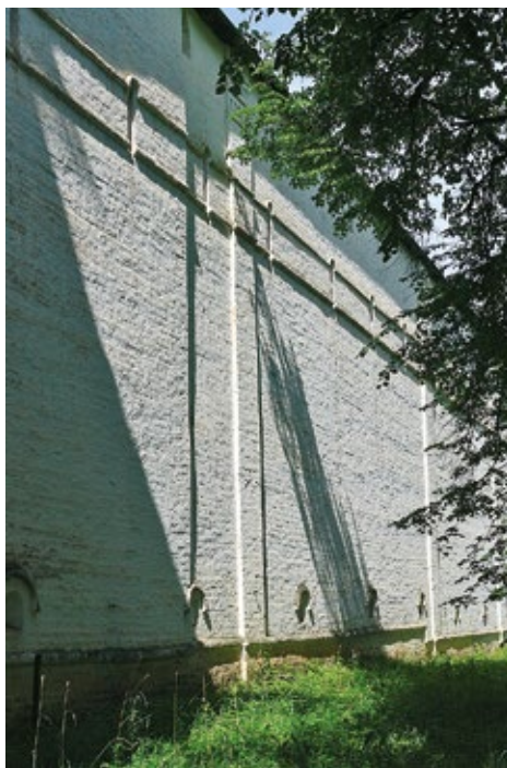
Рис. 12. Тип 2 прясел: прясла с лопатками и не выступающей верхней частью. Прясло между башнями Северо-Восточной и Малой северной восточной стены. Фото автора, 2023 г.
