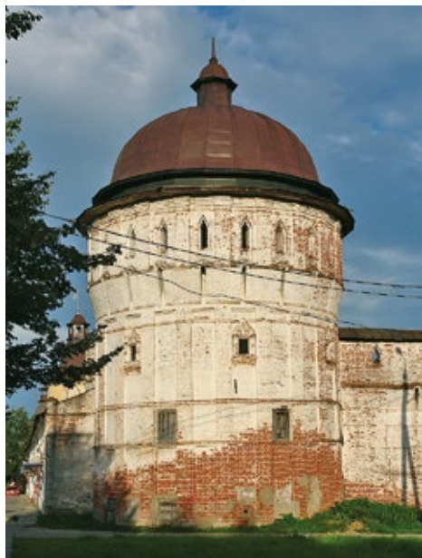
Рис. 5. Северо-Западная башня Борисоглебского монастыря, вид снаружи. Фото автора, 2023 г.
