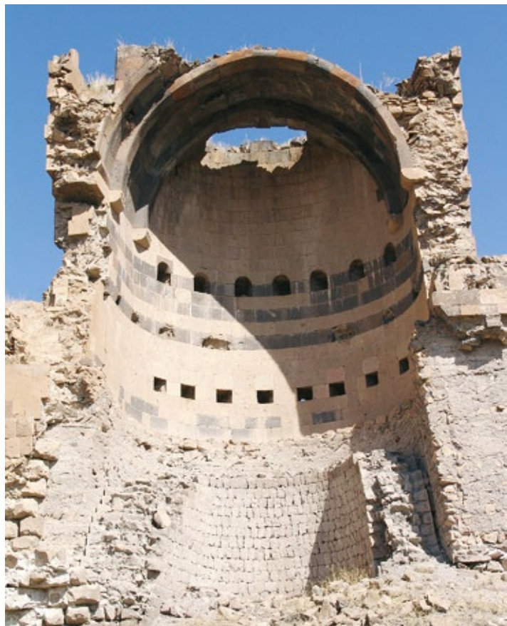
Рис. 9. Башня № 8 с внутренней стороны. Фото А. Казаряна, 2005
