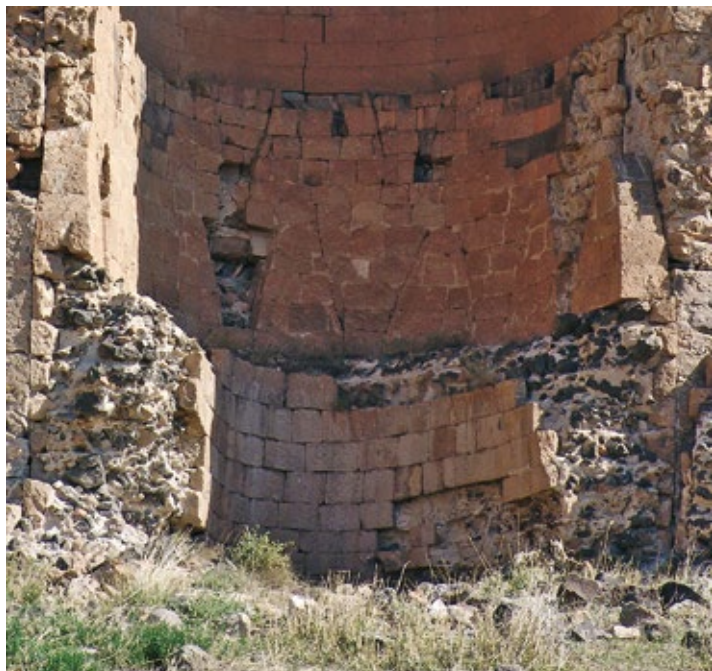
Рис. 7. Башня № 18. Внутренняя сторона. Фрагмент с двумя рядами мерлонов. Фото А. Казаряна, 2005
