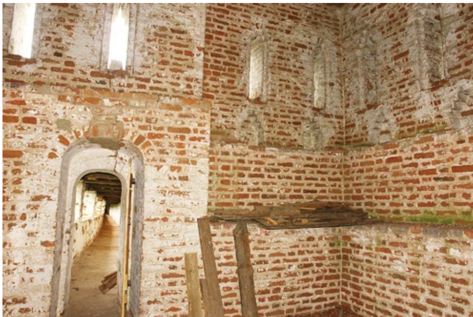
Рис. 10. Верхние ярусы Малой южной башни восточной стены. Слева виден дверной проем, выводящий на боевой ход прясла. Справа стены имеют два уступа. На верхнем уступе раньше располагался мост 4-го яруса башни. Фото автора, 2023 г.
