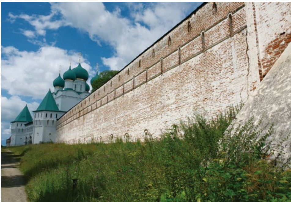
Рис. 13. Тип 3 прясел: прясла без лопаток и без выступающей верхней части. Прясло между воротным комплексом у ц. Сергия и Юго-Восточной башней. Фото автора, 2023 г.
