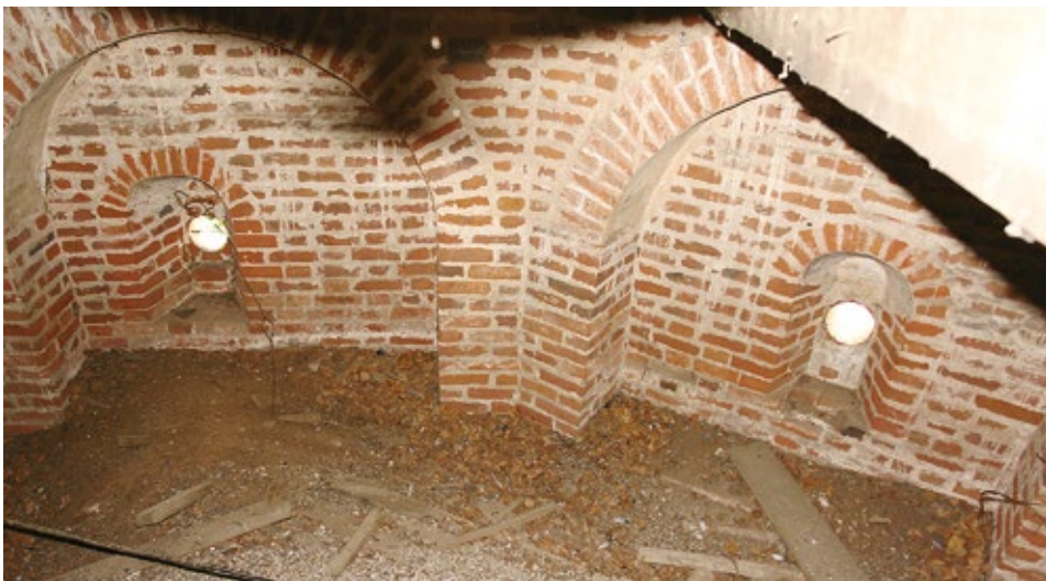
Рис. 8. Второй ярус Юго-Восточной башни. Видны печуры с нишами у круглых бойниц. Фото автора, 2023 г.
