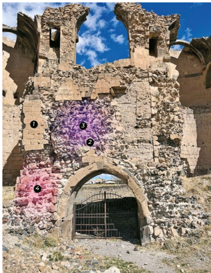
Рис. 5. Центральная зона Карсских ворот Ани, с обозначением отдельных форм и массивов кладки конца X в.: 1 — поверхность боковых участков кладки; 2 — остатки верхней арки проема; 3 — бутобетон зоны над аркой; 4 — массив кладки сбоку от проема
