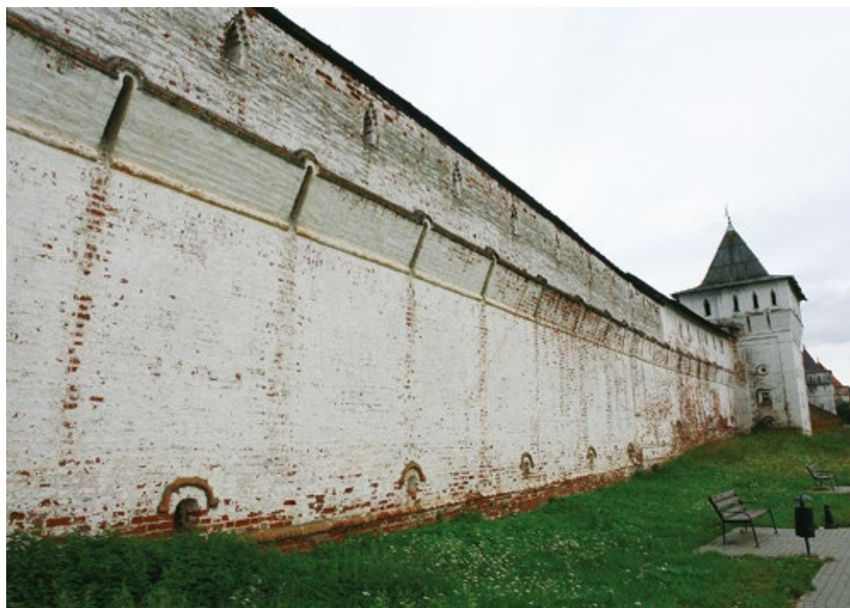
Рис. 11. Тип 1 прясел: прясла с сильно выступающей наружу верхней частью и двойным полуваликом над отверстиями машикули. Прясло между башнями Северо-Западной и Западной у кладовых. Фото автора, 2023 г.
