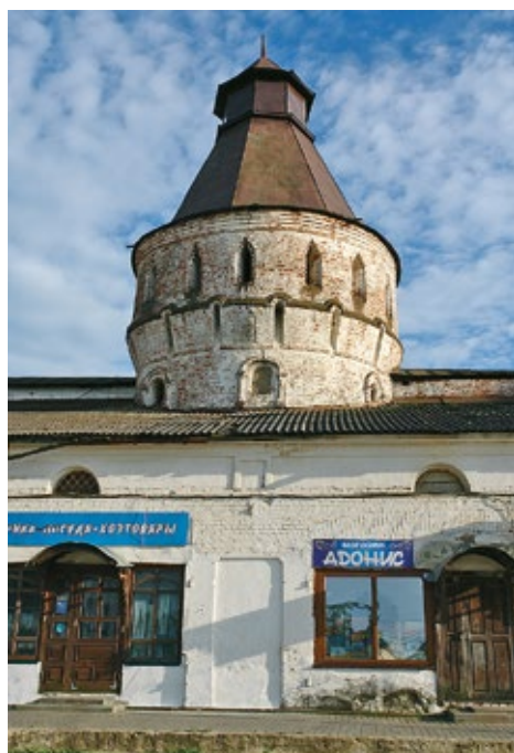
Рис. 7. Круглая башня северной стены, вид снаружи. Фото автора, 2023 г.
