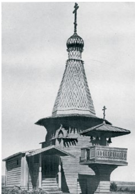
Рис. 18. Звонница на одном столбе с площадкой и кровлей Ильинского храма в Усть-Вье. 1600 г.
