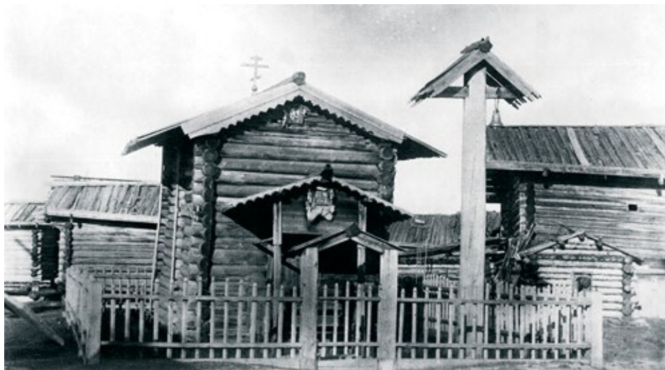
Рис. 15. Часовня, д. Машканово (Верхнетоемский район), фото 1921 г.
